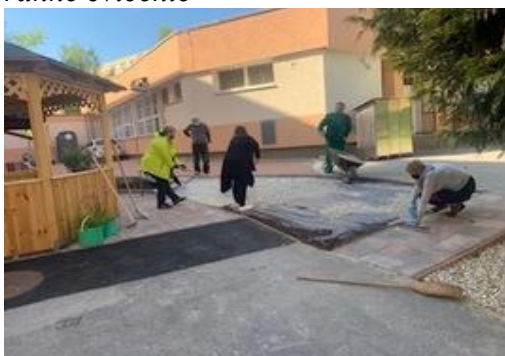
úprava vnútorného areálu
